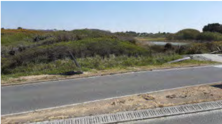
Ecoulement 6 au niveau du passage sous la route D152
